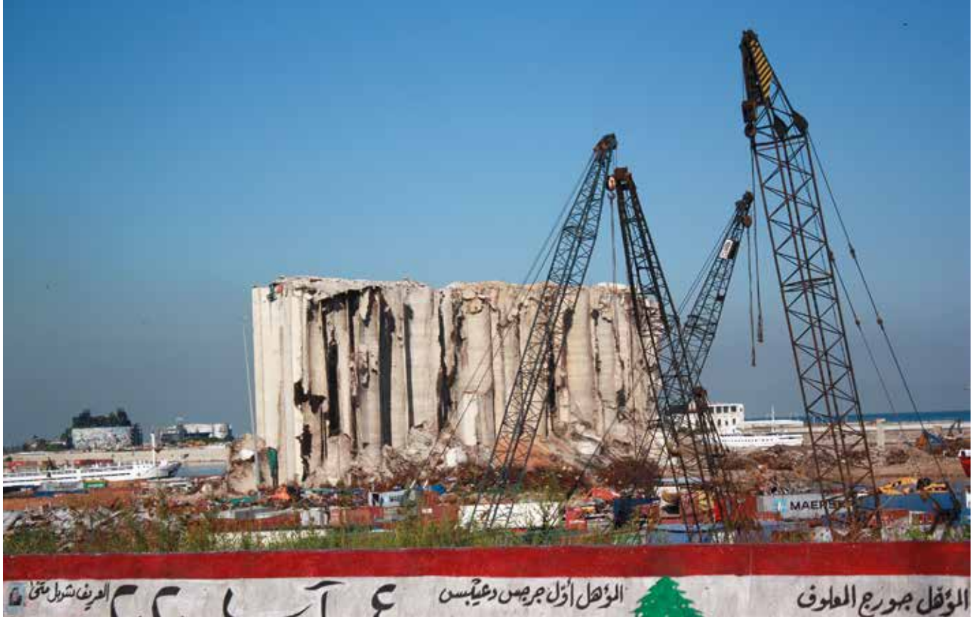
Der zerstörte Getreidesilo im Beiruter Hafen. - Symbol der Explosionskatastrophe vom 4. August 2020.
